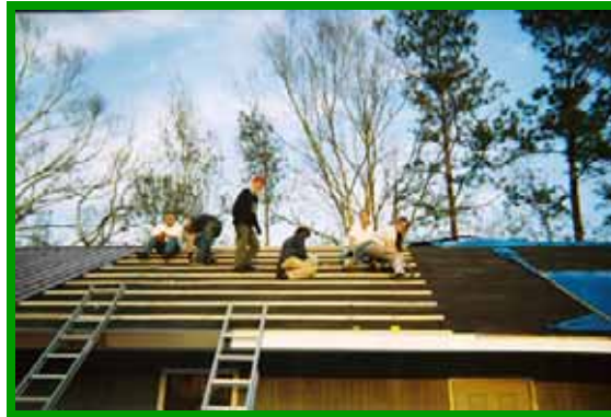
Reparatur eines von Katrina zerstörten Daches in Mississippi
