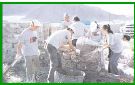
Freiwillige von RYS beim Wiederaufbau einer Mauer in der Mongolei
