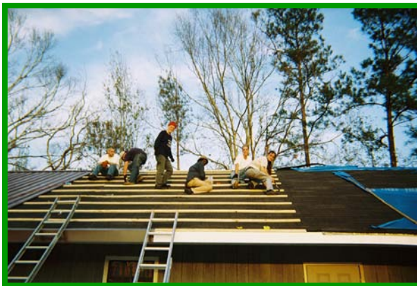
Réparation d'un toit abîmé par Katrina dans le Mississippi
