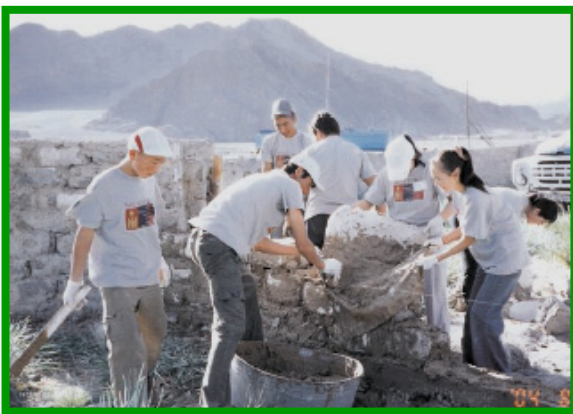
Монголия, 2001 год. Волонтеры RYS отстраивают стену
